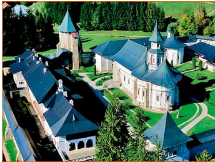
Figura 25 – Mănăstirea Putna construită între anii 1466–1469
