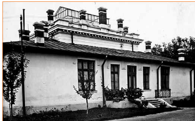
Figura 29 – Pavilionul de Parazitologie, unde a fondat Ion Ciurea laboratorul și muzeul după anul 1919
