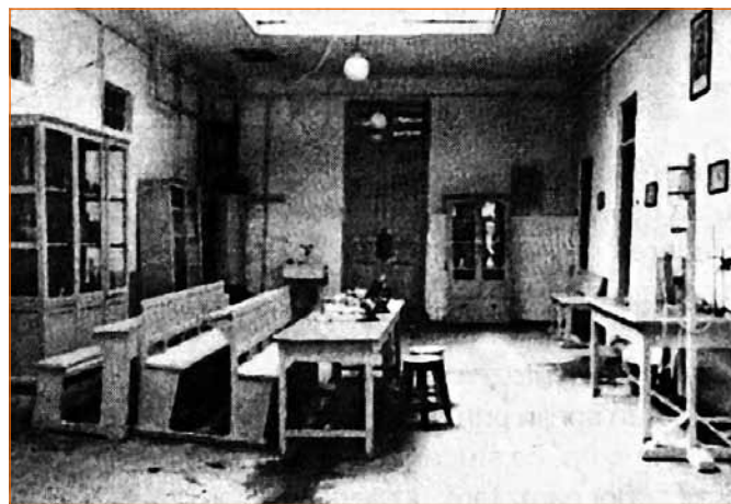
Figura 38 – Sala de Clinică pentru studenții anului V – actualmente clădirea este demolată
