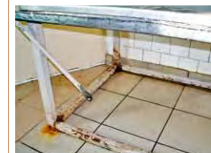
Deficiențe privind întreținerea echipamentelor
