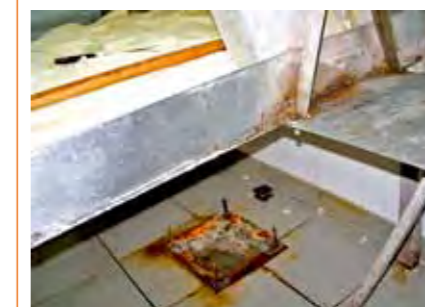
Deficiențe privind întreținerea echipamentelor și a canalizării
