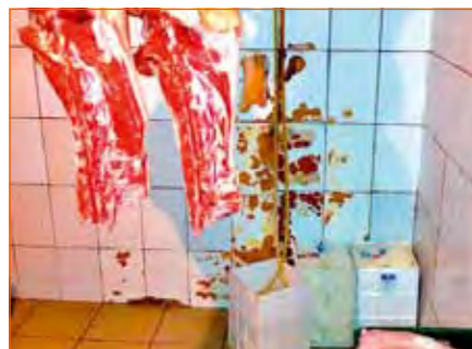
ⓘ Întreținerea necorespunzătoare a spațiului destinat depozitării alimentelor
