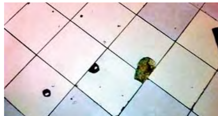
Întreținerea necorespunzătoare a pavimentului
