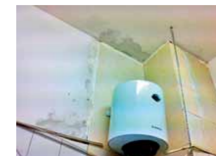
Neîntreținerea plafonului și a pereților
