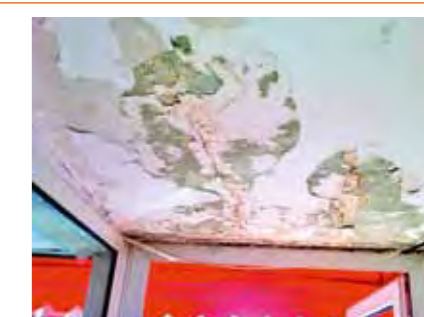
Degradarea avansată a plafonului
