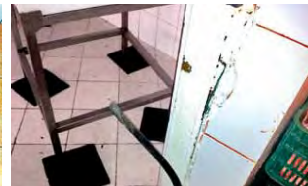
Neîntreținerea pereților și a sistemului de izolare a ușii camerei frigorifice
