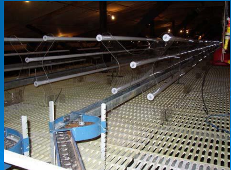
Pregătirea pentru populare a unui adăpost cu sistem de cazare pe stinghii
